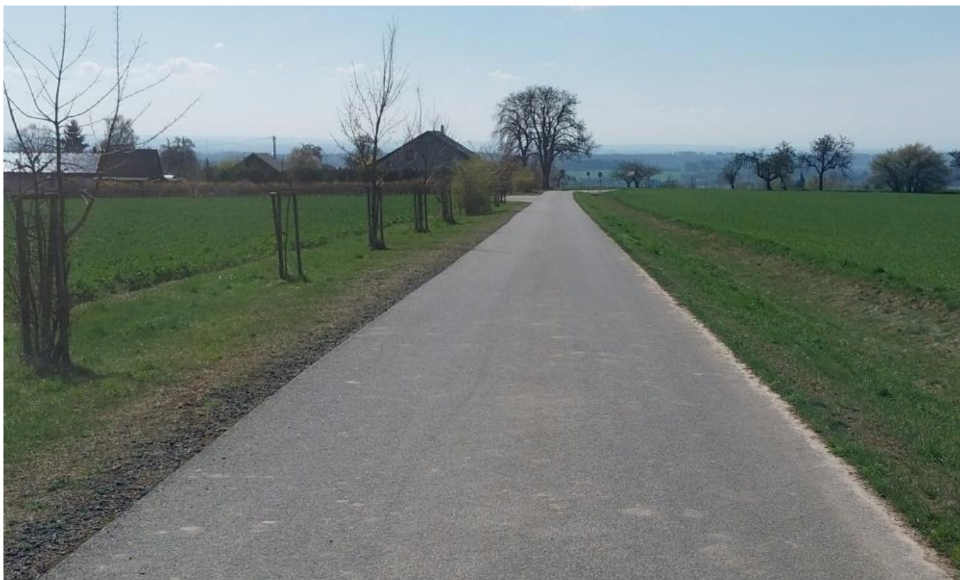
Účelová komunikace HC2 – šířka asfaltového povrchu 3,5 m + zpevněné krajnice 0,6 – 0,8 m (směr sjezd III/2856)
