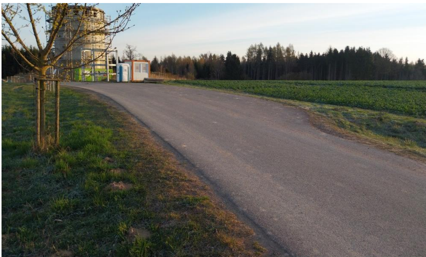
Účelová komunikace HC2 – třetí výhybna délky 30 m a šířky 3 m (km 0,797-0,827)
