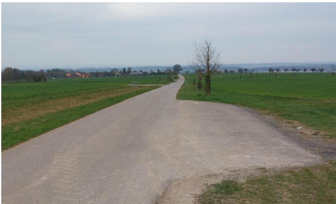
Účelová komunikace HC2 – výjezd z účelové komunikace HC2 délky 14,7 m a šířky 3 m (km 0,612-0,626) – pohled směr křížení HC2 a VC23, směr první a druhá výhybna a sjezd III/2856
