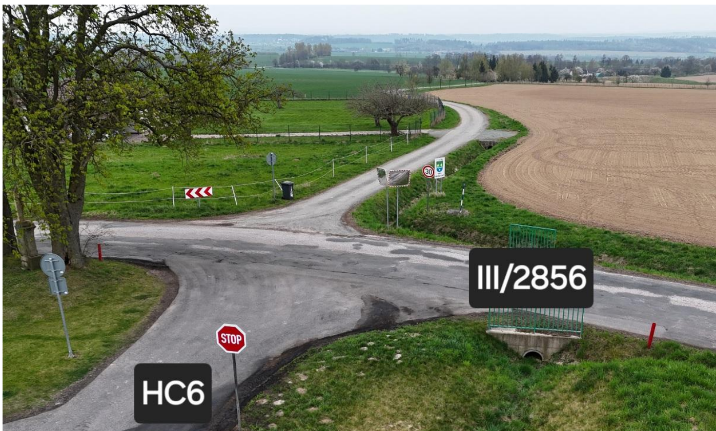
Výjezd z účelové komunikace HC2 (hlavní cesta HC2) na komunikaci (silnice) III/2856 (vlevo směr Hřibojedy a vpravo směr Libotov), dle projektové dokumentace a realizace č.j. ODP/5080-2012/1044-2012 (fotografie 04/2026)
