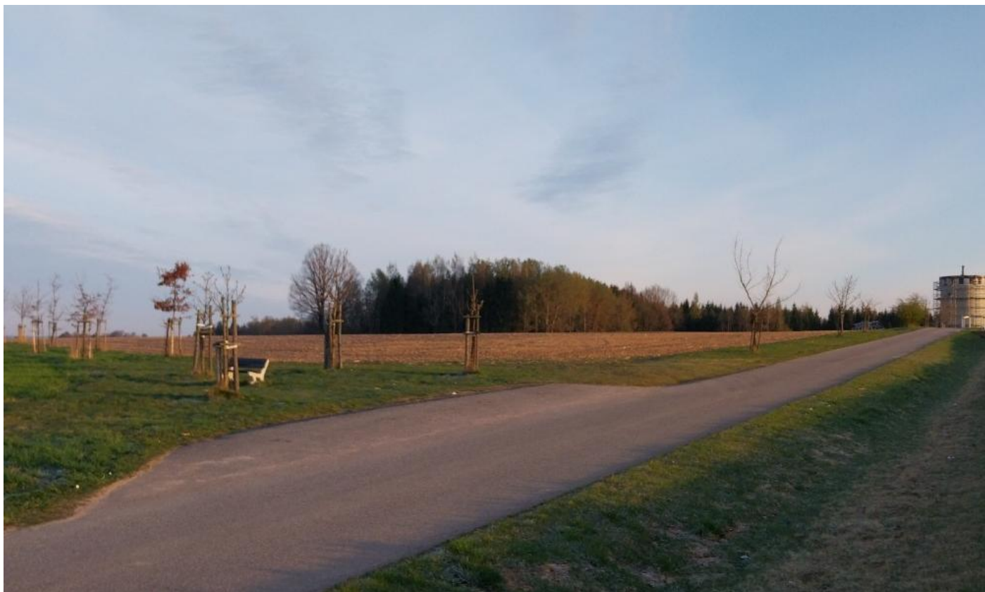
Účelová komunikace HC2 – výjezd z účelové komunikace HC2 délky 14,7 m a šířky 3 m (km 0,612-0,626) – pohled směr vodojem a rozhledna
