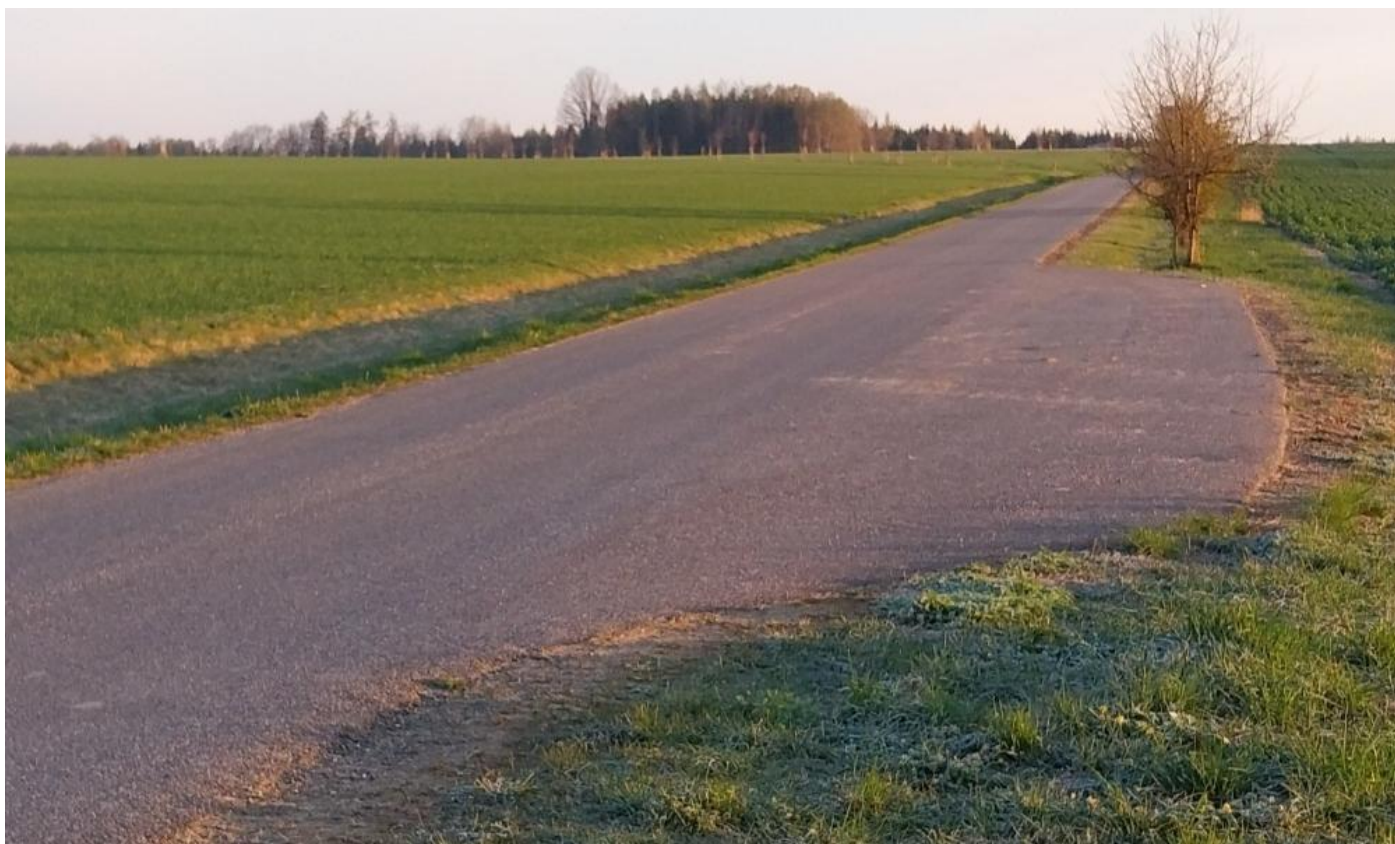
Účelová komunikace HC2 – první výhybna délky 30 m a šířky 3 m (km 0,087-0,117)
